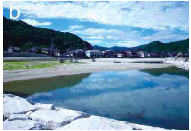
図3 突堤及び消波ブロックの設置による砂浜面積の変化：諸寄海水浴場で（a）2009年8月15日及び（b）2010年7月17日に撮影された写真。
