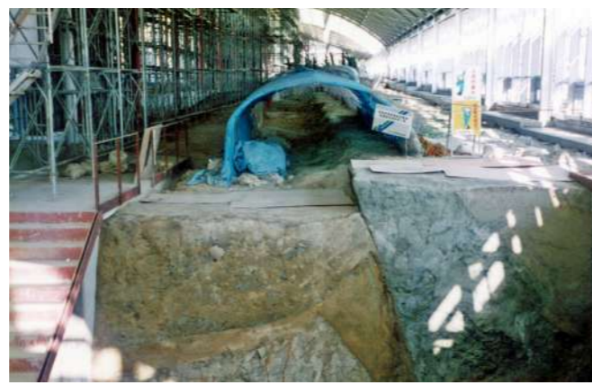
写真2 保存工事中の野島断層保存館内 1998年1月27日、トレンチ展示付近
