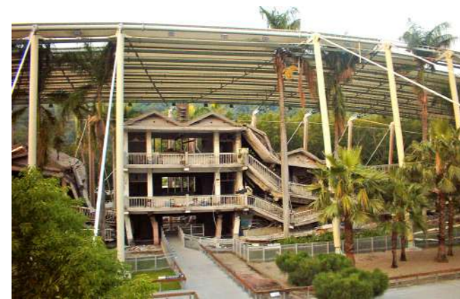
写真3 921地震教育園区で屋外保存されている倒壊校舎
