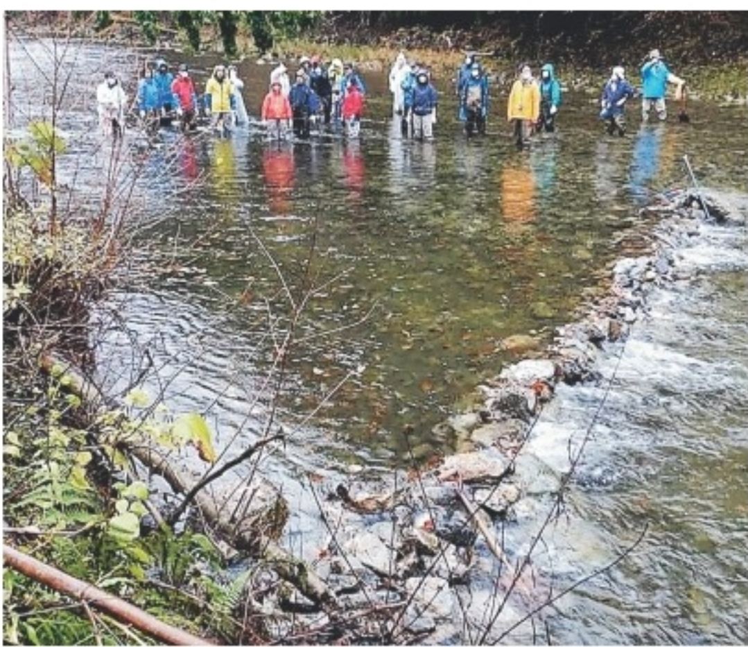
石組みによって、水生生物の隠れ家や餌となる落ち葉をたまりやすくする取り組み＝京都府南丹市美山町
