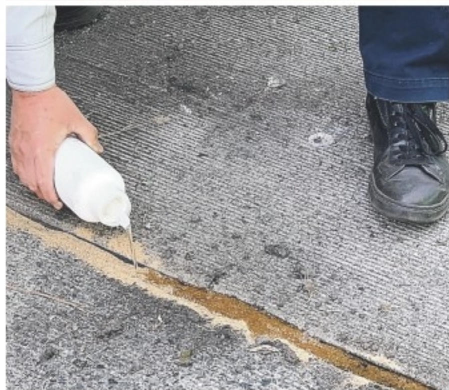
シリコン樹脂による亀裂の補修作業
