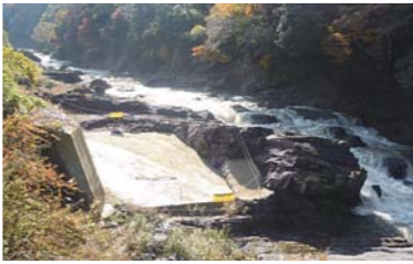
第4次発掘直前の発掘現場
