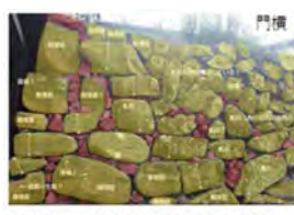
打ち込みハギ中の後から打込んだ石には加工された花崗岩（ピンク）が用いられている。
