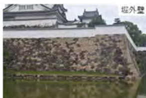
切り込みハギ中の花崗岩。黒く見える岩石の多くは砂岩である。
