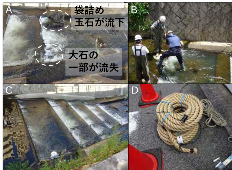
図2 津門川に設けられた階段式魚道の整備状況. A: 2024年5月28日の出水で破損した魚道. B: 施工の状況. C: 施工後の魚道の概観. D: 新たに魚道側面に設置したロープ.
