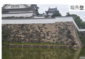
切り込みハギ中の花崗岩。黒く見える岩石の多くは砂岩である。
