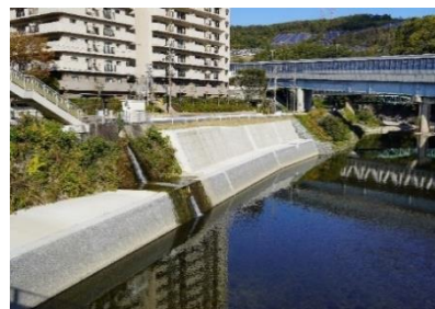
写真6 護岸改修後の生瀬橋上流側景観
