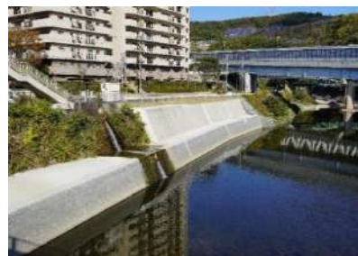
写真6 護岸改修後の生瀬橋上流側景観
