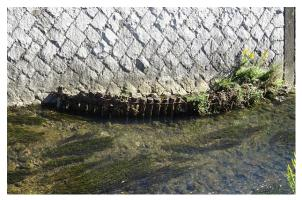
ら魚道との間に25カ所新設された。その後、老朽化して、一部は流出し、壊れた状態で放置されており、景観上も好ましい姿ではない。既存の水生植物育成地のサイズ・形状・劣化状態などを参考として、新たな工法を適用して改修すれば、津門川の治水対策の障害にならないと考えます。
