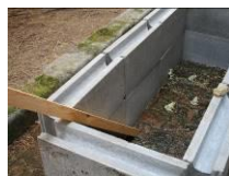
図3 スロープあり
