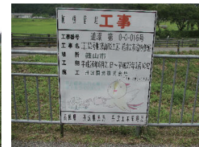
図4 河川工事(B地点)
