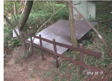
ポンプ小屋付近の改修
