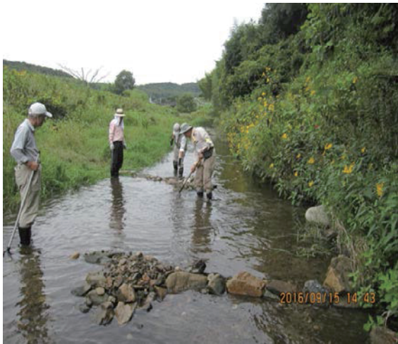
写真5 川づくり作業中
