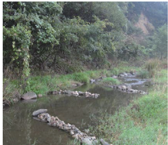
写真6、川づくり作業 完成
