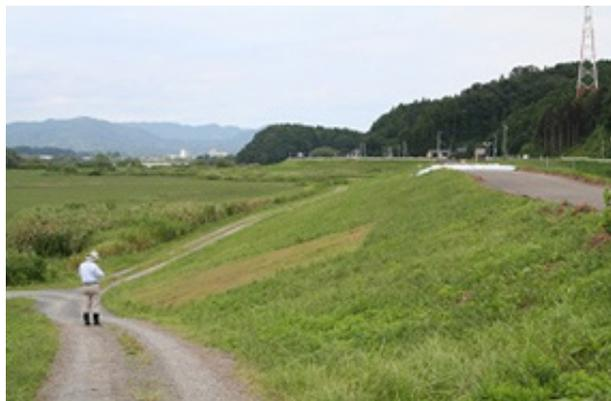
写真 7-8 震災により亀裂が生じた河川堤防法面
