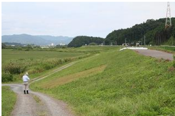
写真 1.河川堤防法面
