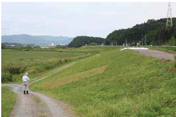
写真 1.河川堤防法面
