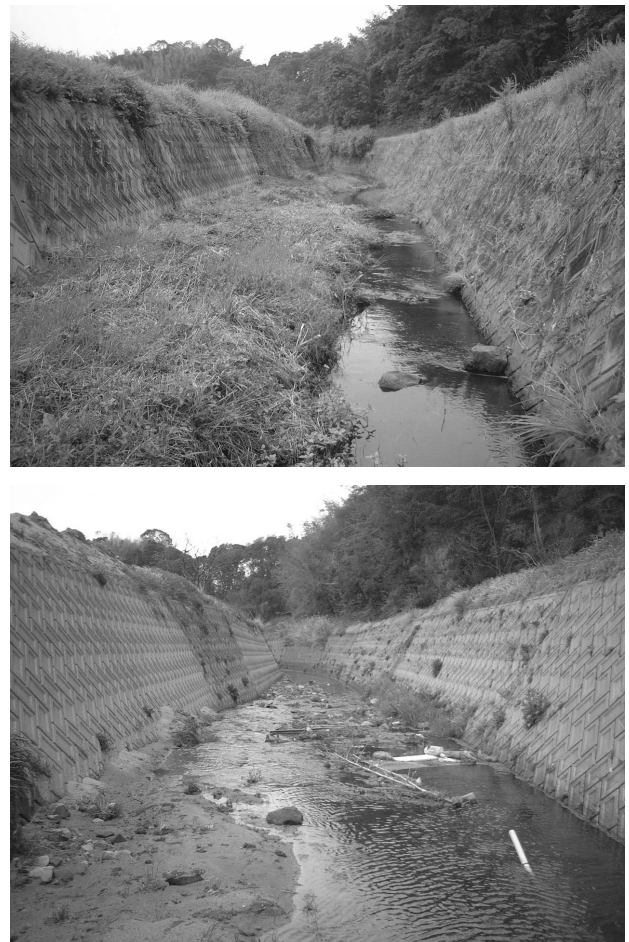
図2 兵庫県淡路市郡家川の出水前後における河道の状況
