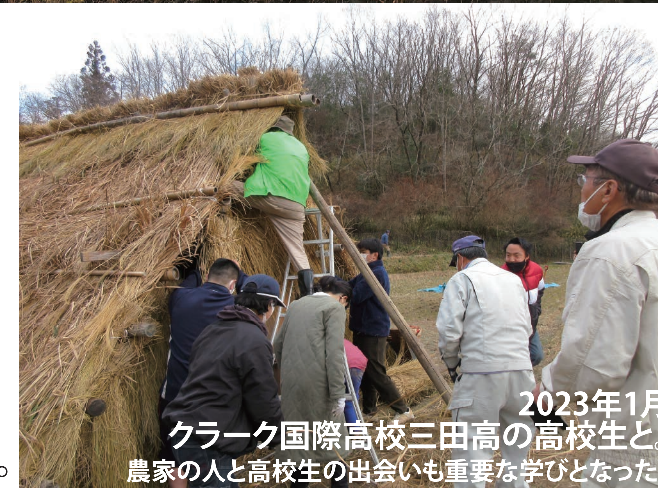
2021年12月 淡路景観園芸学校の大学院生とウド小屋づくり ウド小屋の風景を県立公園内に再現。どれだけの作業量が必要なのかも体感した。
