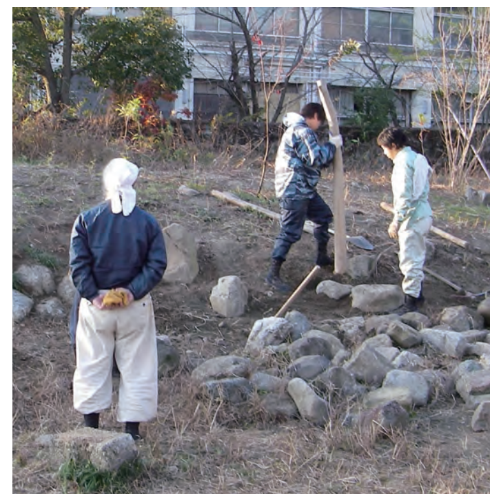
庭づくりで石を据える作業風景
