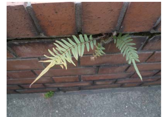
4. 神戸市中央区楠町 神戸市立中央図書館 レンガのすき間。1970年代から知られる。10株程度
