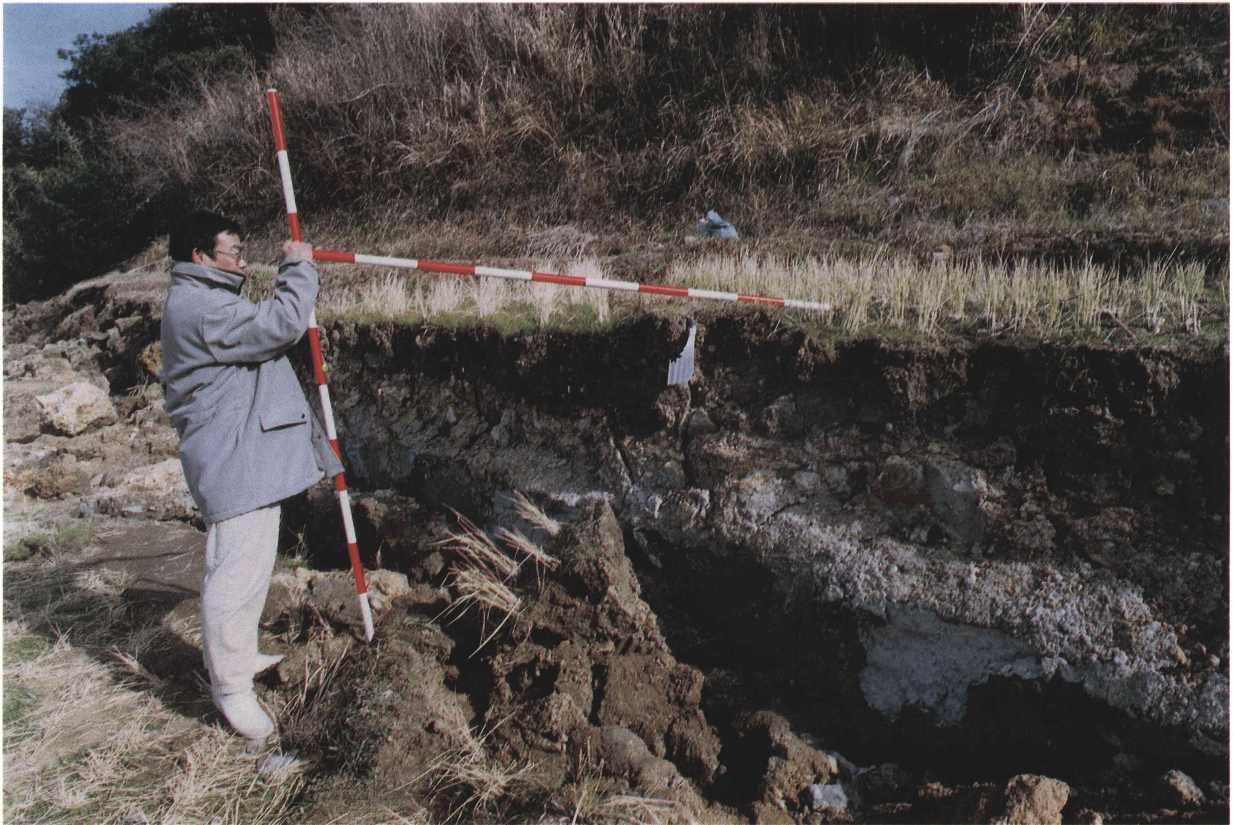
写真3 北淡町平林に現れた野島地震断層の近接写真(1995年1月20日頃朝日新聞社撮影)
