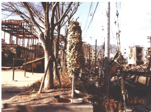
写真5. 長田区 水笠西公園。(1995年1月29日 撮影者：上浦木昭春) 火災により片面だけ枯損したヘデラ緑化フェンス。写真左手のケヤキの幹はフェンスにおおわれていなかった部分だけ炭化、黒変したと考えられる。
