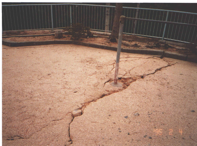
写真3. 須磨区 北一の谷公園。(1995年2月4日) 斜面地開発の盛り土上に位置するこの公園には大きな亀裂が走っていた。写真は公園内から垂直擁壁に向かって走る亀裂の一つ。近隣の住民は「崩壊が怖いので、公園内に立ち入らないようにしている」と話してくれた。擁壁はわずかに傾いていた。
