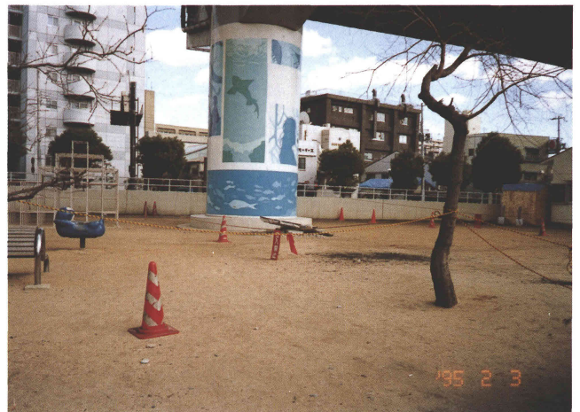
写真6. 須磨区 衣掛公園. (1995年2月3日) 高速道路からの落下物が転がっている。小さなコンクリート片などがほとんどの橋脚のまわりで見られるが、大きな破片のまわりだけがロープで隔離されている。
