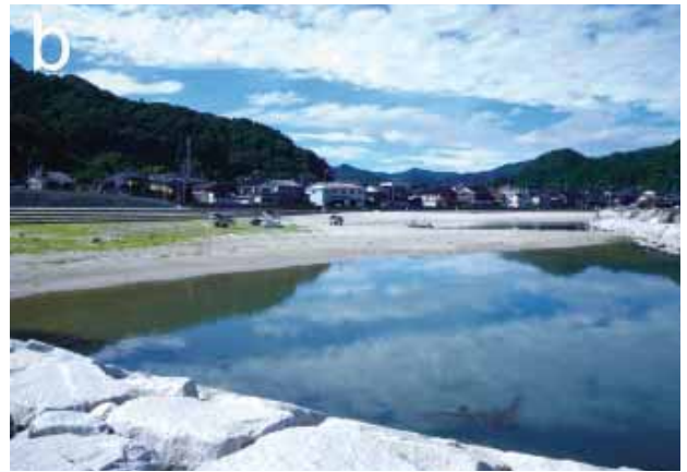
図3 突堤及び消波ブロックの設置による砂浜面積の変化：諸寄海水浴場で (a) 2009年8月15日及び (b) 2010年7月17日に撮影された写真。
