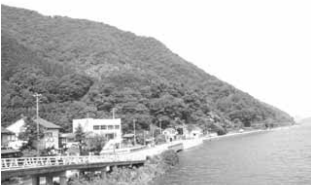
図11 豊岡市城崎町来日橋の円山川左岸(円山川河口まで5.3 km地点)の地形景観。豊岡盆地-津居山湾の円山川両岸にはまとまった低地がなく山地が迫り，道路や鉄道は護岸された堤防沿いを走っている。来日橋付近の道路面の標高は1 mくらいで，写真中央の白い建物の右側でボーリング調査が行われた。それによると未固結層は深度58 m以上に達していることから，未固結層堆積前の古円山川はこのあたりでは地下60 m位のところを流れ，現在の円山川下流部には急峻なV字谷が発達していたと考えられる。V字谷は円山川の約1万年前以降の堆積物で埋め立てられ，現在に至っている。
