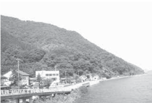
図11 豊岡市城崎町来日橋の円山川左岸（円山川河口まで5.3 km地点）の地形景観。豊岡盆地 - 津居山湾の円山川両岸にはまとまった低地がなく山地が迫り，道路や鉄道は護岸された堤防沿いを走っている。来日橋付近の道路面の標高は1 mくらいで，写真中央の白い建物の右側でボーリング調査が行われた。それによると未固結層は深度58 m以上に達していることから，未固結層堆積前の古円山川はこのあたりでは地下60 m位のところを流れ，現在の円山川下流部には急峻なV字谷が発達していたと考えられる。V字谷は円山川の約1万年前以降の堆積物で埋め立てられ，現在に至っている。
