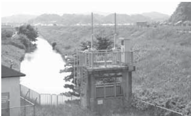
図 15 前川樋門。写真右上の堤防上の樋門は森津樋門。
