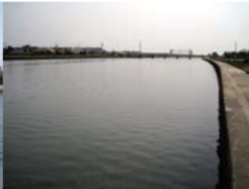
コンクリートで固められた下流域も水際が再生されます。
