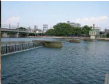
最下流にある潮止め堰によって、アユなどの堰が阻害。この堰が撤去されます。
