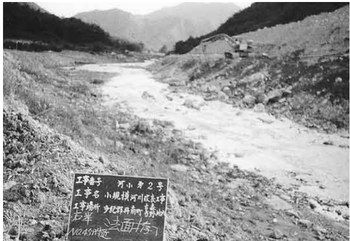
写真1 30年以上前に行われた武庫川上流・当野地区岩鼻橋付近の河川改修の様子。法面から川床に至るまで全て破壊された。(兵庫県篠山土木事務所提供)
