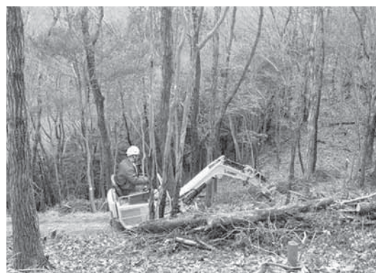
歩道開設工事中
