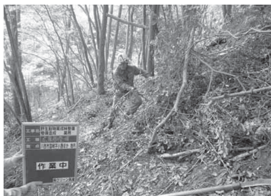
森林整備工事中
