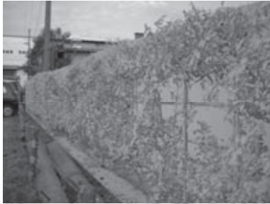
ハンギングポットを利用した壁面緑化
