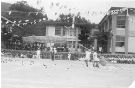
三河小学校の旧校舎③ 左奥の校舎が建てかえられ、今は全ての校舎がつながっています。
